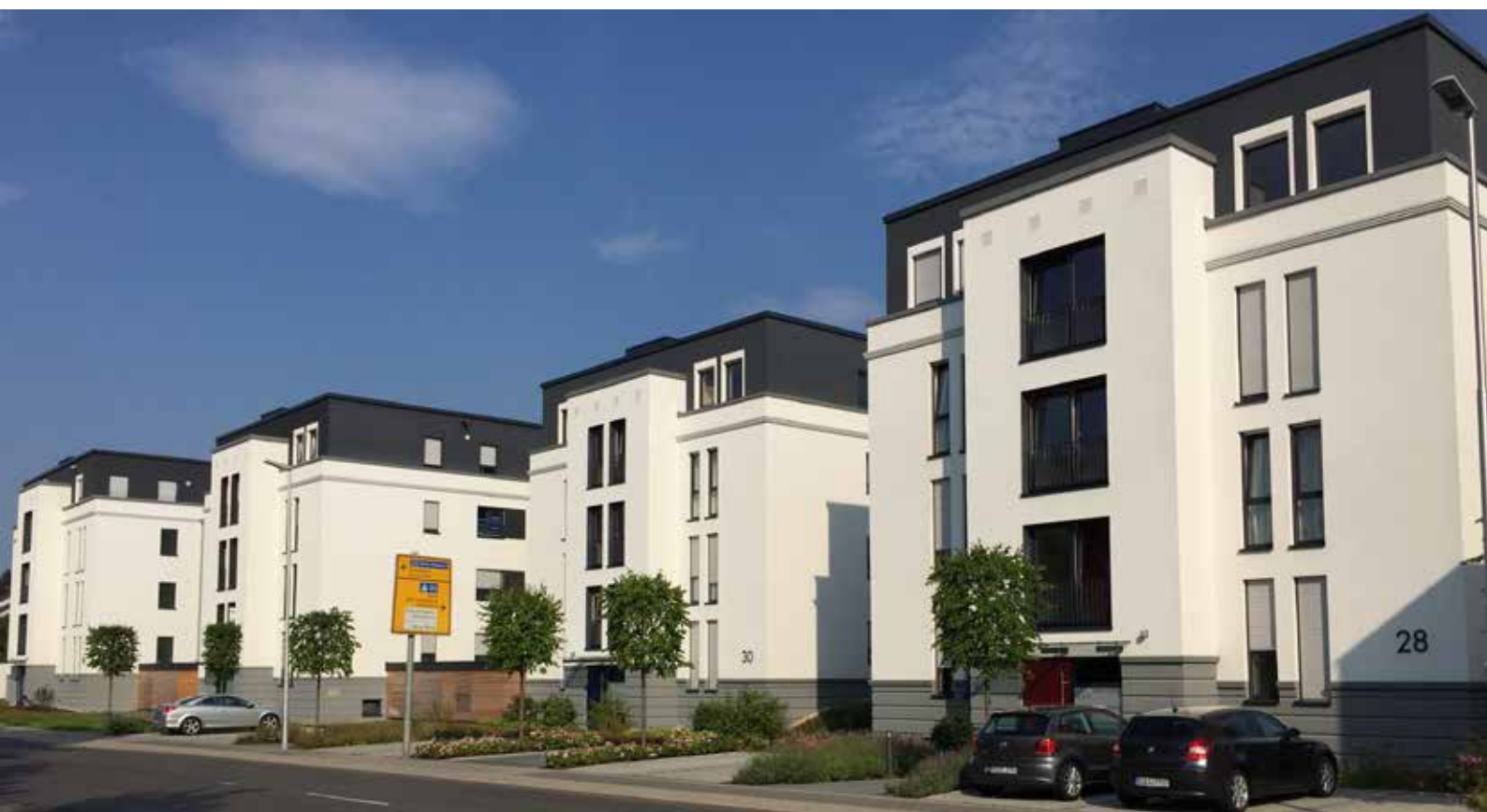
Abbildung 6: Tor zur Stadt mit urbaner Architektur: das Kurfürstenquartier. Eigene Aufnahme
